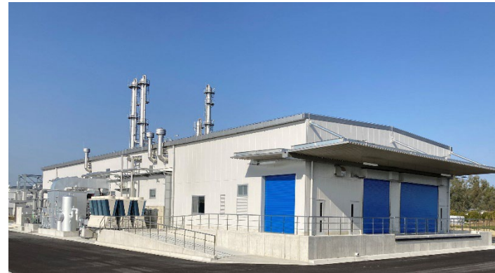
2024.3月 淡路工場 第2屋内充填所 完成
