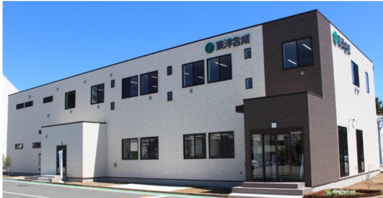
2023.8月 香料工場 管理分析棟 完成
