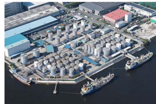
高浜油槽所の全景 石油以外の化学品では、東京湾内最大のケミカルタンクターミナル
