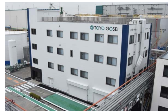
分析室が入る新管理棟（2018.5竣工） 分析設備を拡充し、品質管理が一層向上
