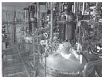
感光材第3工場の増強ラインは4月に稼働した（写真は反応設備）
