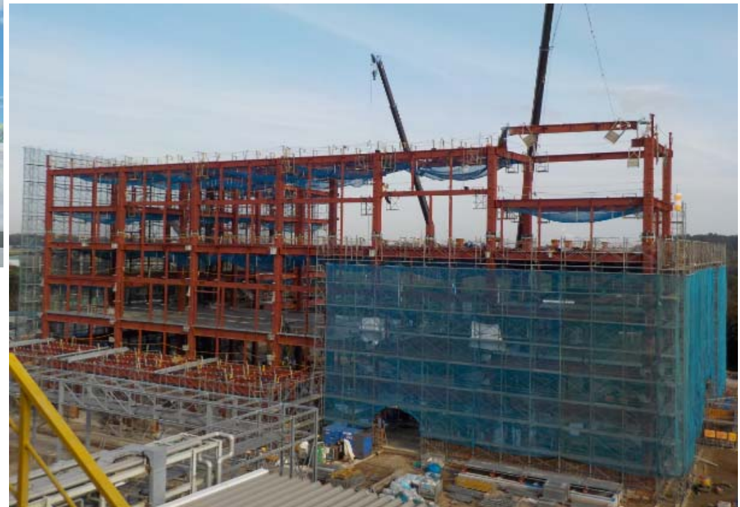
工事進捗状況（2019年10月31日現在）
