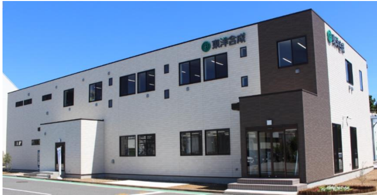
2023.8月 香料工場 管理分析棟 完成
