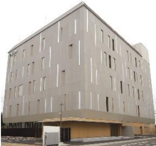
2024.5月 千葉工場 開発分析棟 完成予定
