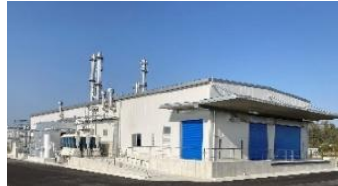
淡路工場 第2屋内充填所 (2024年3月)
