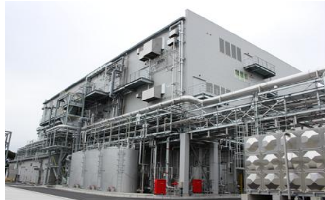
千葉工場 第4感光材工場 先端品生産ライン 完成 (2024年9月)
