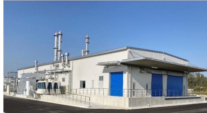
淡路工場 第2屋内充填所 完成 (2024年3月)
