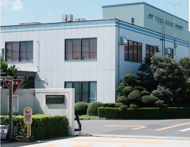
千葉工場外観
