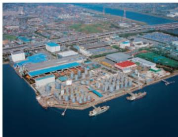
ロジスティック事業を扱う高浜油槽所は、東京湾岸の中心に位置し、首都高速道路網へ2分でアクセスできる最適な立地条件にあります。43,000㎡の広大な敷地に様々な容量、材質、機能を持つ化学品保税タンク61基（総容量51,400kl）設置し、効率的なサービスを提供しております。
