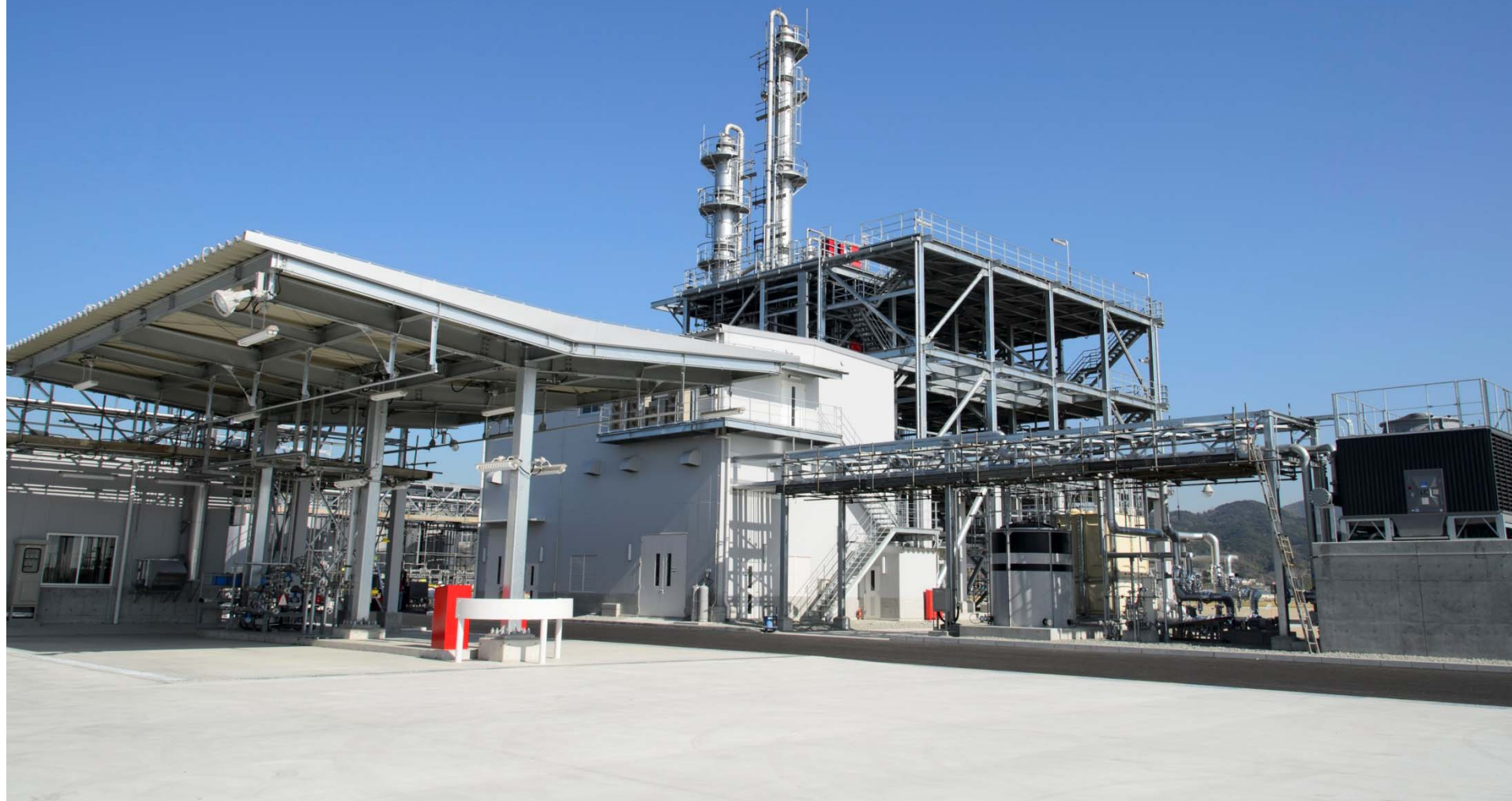
淡路工場 (兵庫県淡路市)
