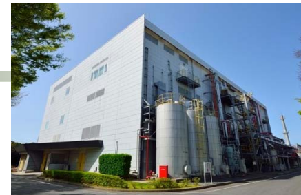
新設ラインを導入した千葉工場の建屋
