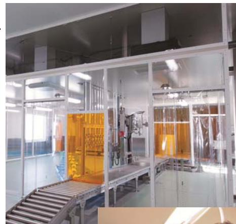
クリーン環境の充填設備で 高純度で管理
