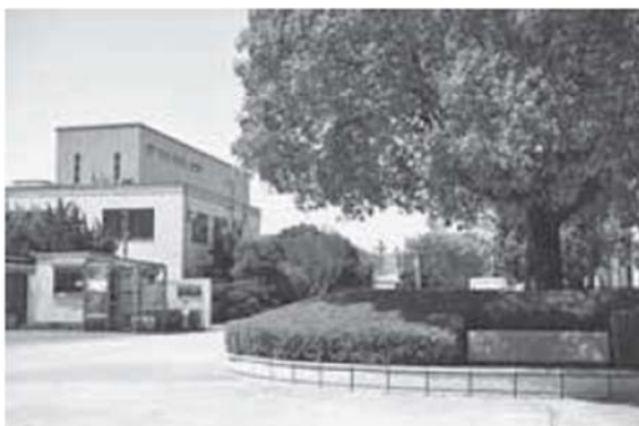
感光性材料の主力生産拠点である千葉工場で相次ぎ設備投資を実施する
