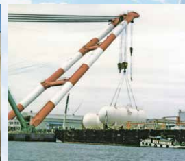
LPG用タンク完成
