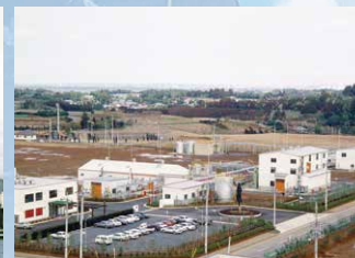
千葉工場竣工
