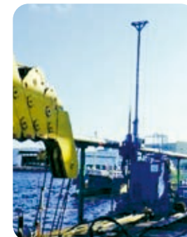
港湾施設の耐震補強工事
