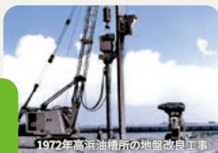
1972年高浜油槽所の地盤改良工事
