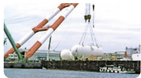
高浜の土地にLPGタンクが据え付けられる
