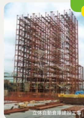
立体自動倉庫建設工事
