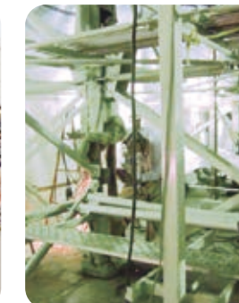
立体自動倉庫の耐震補強工事
