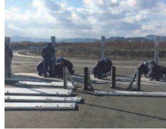
淡路工場正面玄関防潮堤設置
