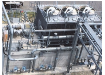
自動運転中冷却塔ファン
