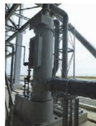
湿式排ガス処理装置
