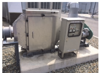
乾式排ガス処理装置
