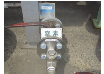
ユーティリティへの省エネ対策表示
