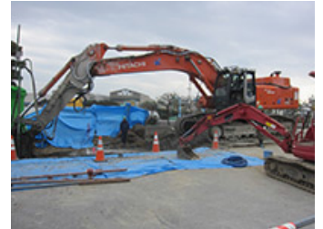
護岸補強工事
