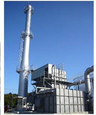
VOC燃焼設備
