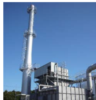
VOC 燃焼設備
