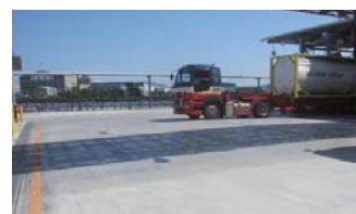
震災復旧工事
