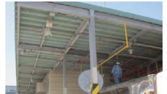
充填所監視カメラ設備
