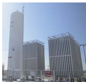
LNG サテライト設備
