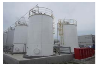
タンクヤード
