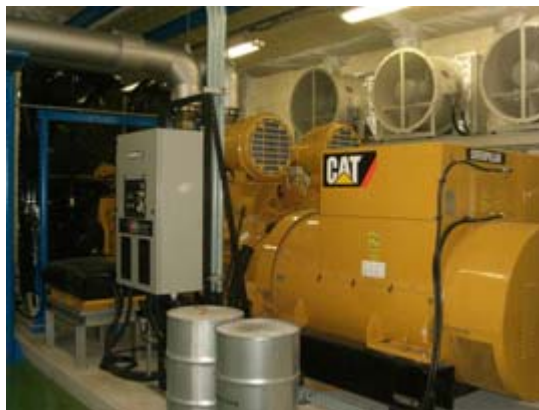
自家発電設備
