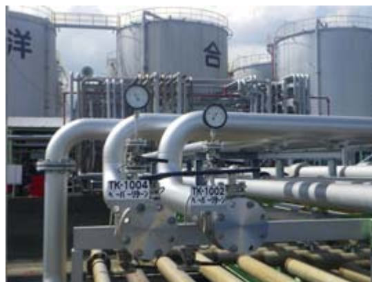
船側ペーパーリターン配管
