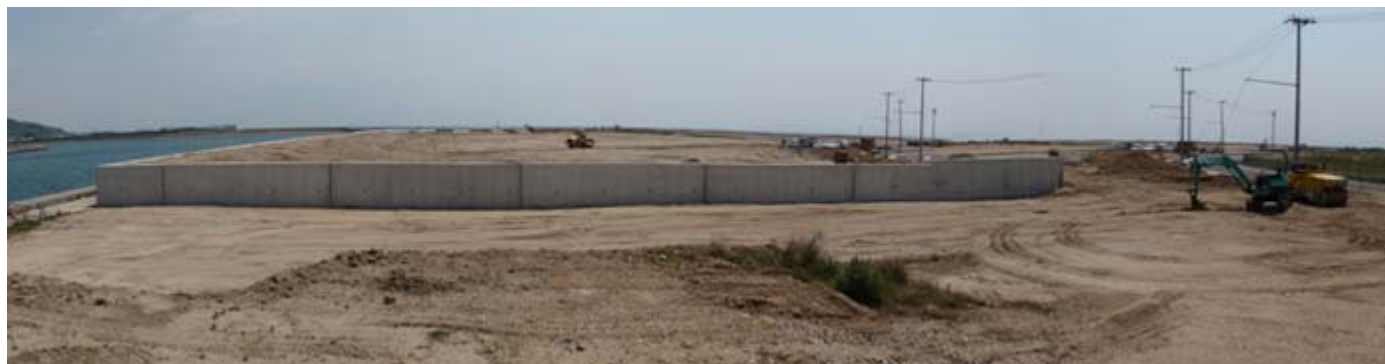
擁壁建設現場
