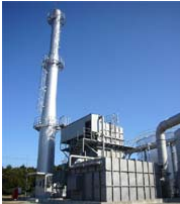
VOC燃焼設備
