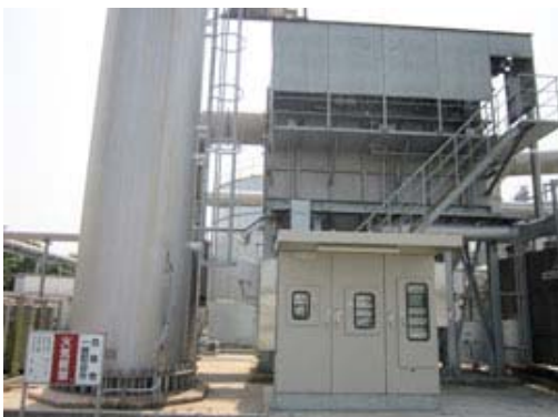
VOC燃焼設備
