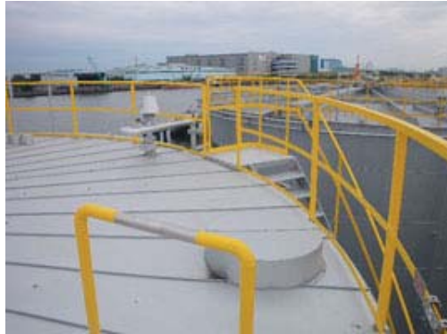
タンク屋根手摺りの更新
