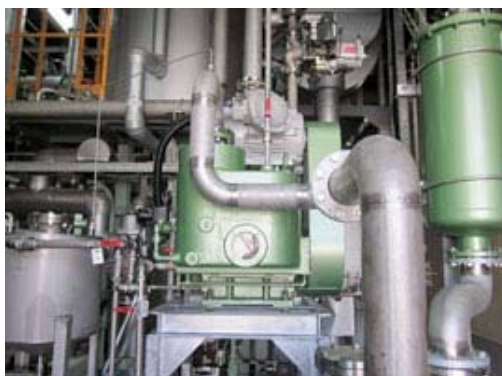
改善後のポンプ
