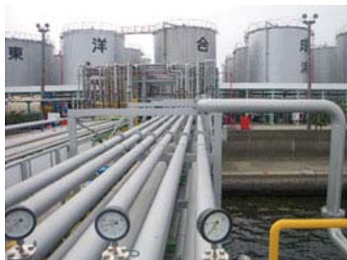
船側ペーパーリターン配管
