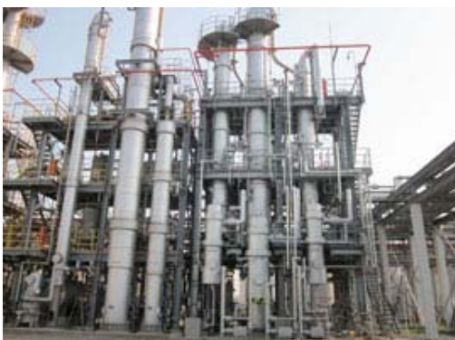
各種精製回収塔
