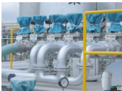
ペーパーリターン配管
