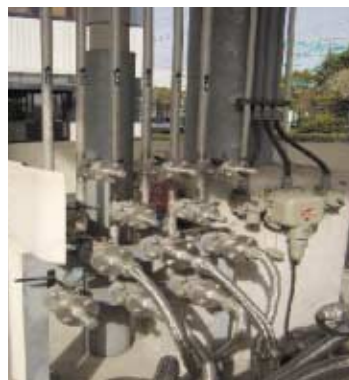
ペーパーリターン配管
