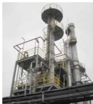
溶剤回収設備
