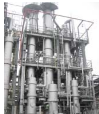
溶剤精製設備
