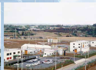
千葉工場竣工
