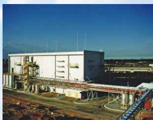
第三感光材工場竣工
