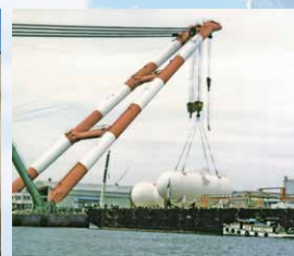
LPG用タンク完成
