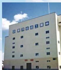
初の感光材製造ラインが完成した市川工場
